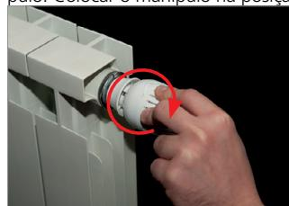
4. O cabeçal está então encaixado na válvula e pode ser colocado na posição de regulação desejada.
