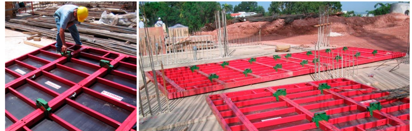
Paneles con Mordazas y Bulones / Pannel with clamp and wedge / Panneaux avec serrure et goupille
