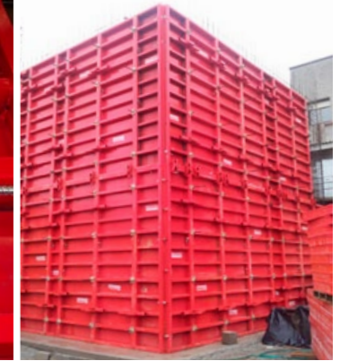
Muro a 2 caras con esquina a 90° 2 faces wall with corner 90° degrees 2 mur à faces avec coin à 90°
