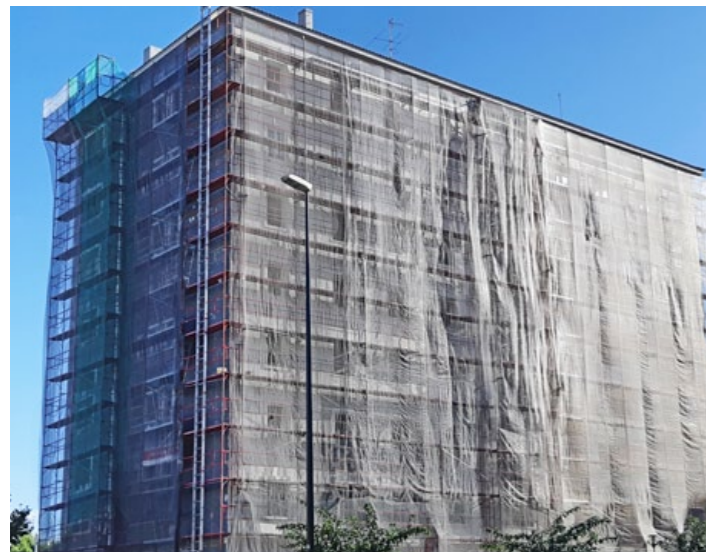
Fachada de andamio FER 48 haciendo esquina.
