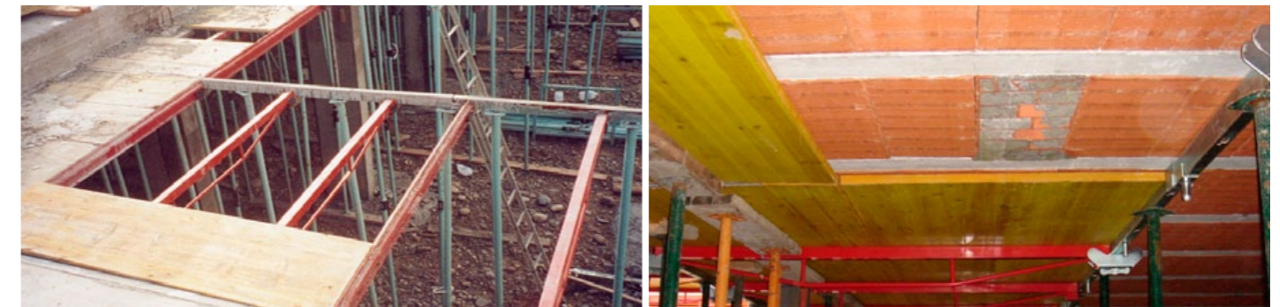
Desencofrado sin reapuntalamiento / Un-formwork without props reinforcement / Re-coffrage sans étaieiment
