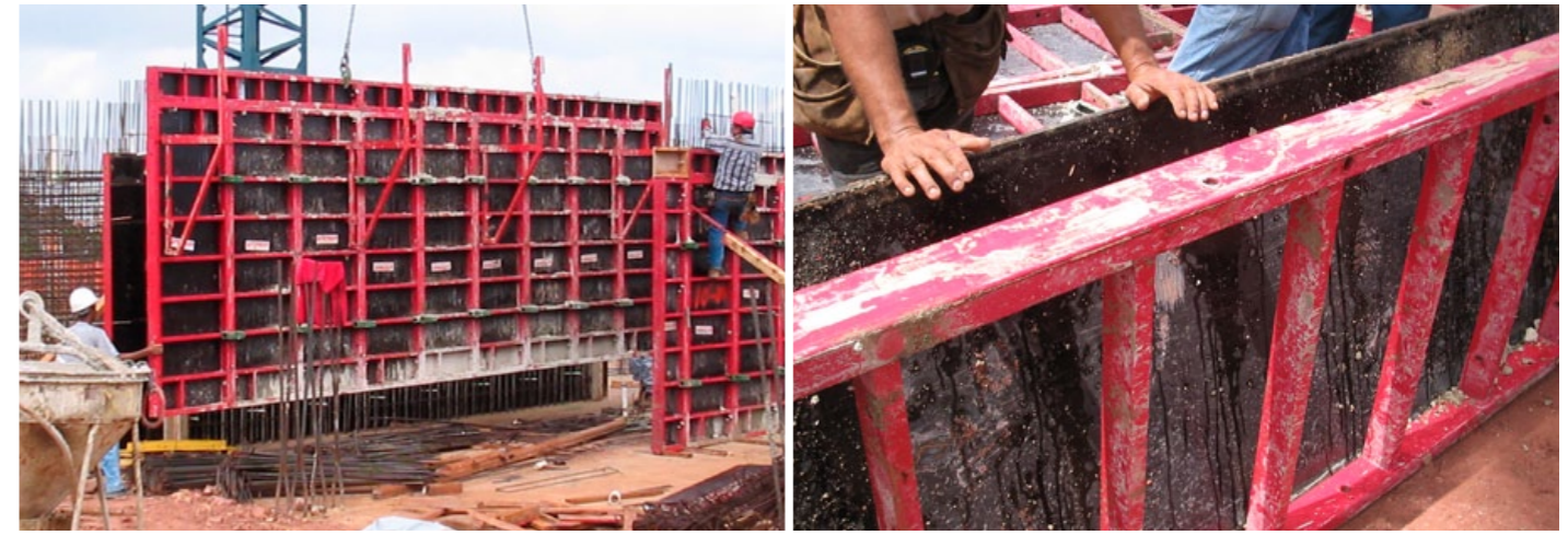
Manipulación de un muro de 24 m 2 .
