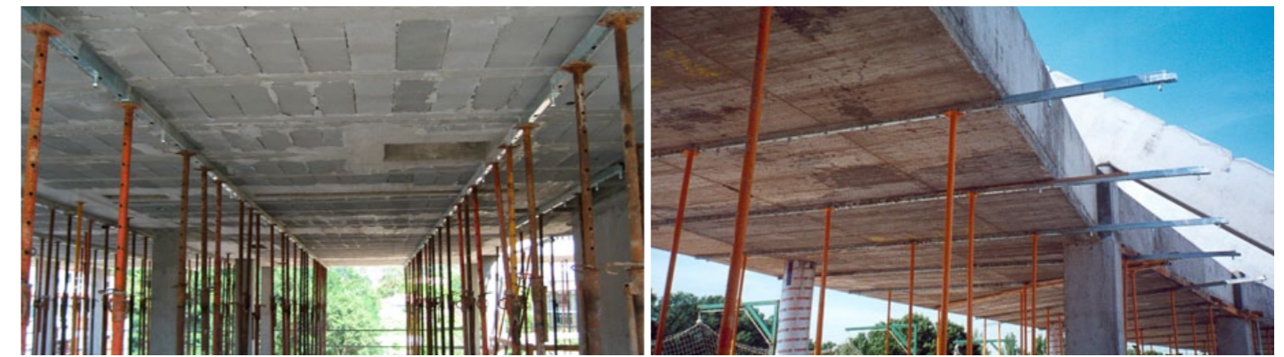
Planta apuntalada 2 m. de luz / Reinforced props floor 2 m. light / Étage étagée avec 2 m. de portée
