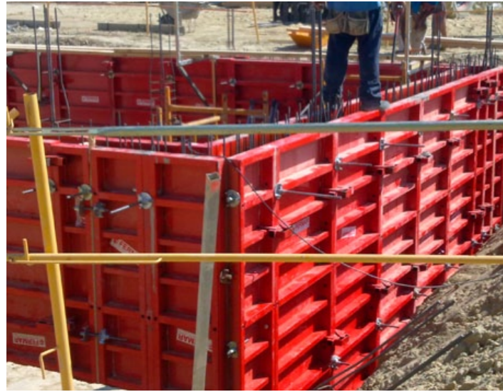
Muro a 2 caras para bodega soterrada.
