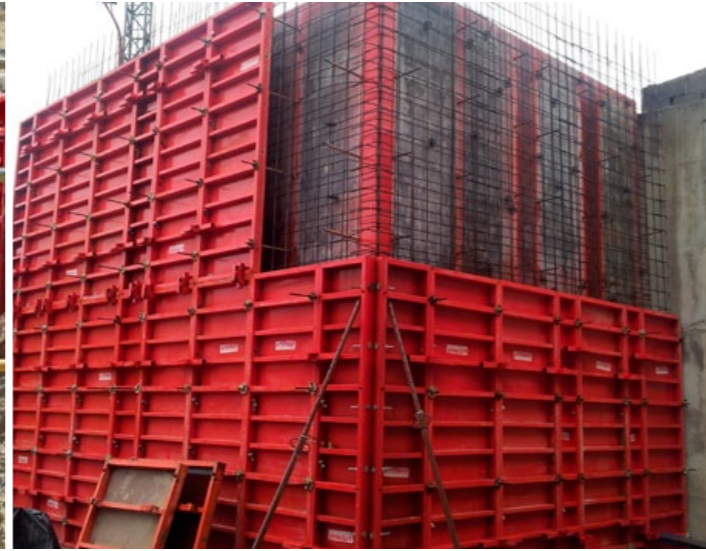
Muro a dos caras para deposito de agua.
